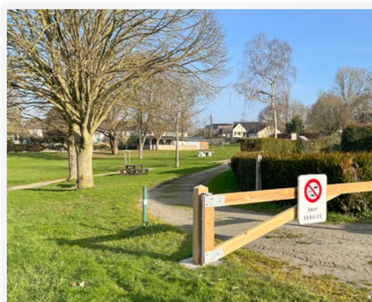
Pour la sécurisation des jeux pour enfants pose d'une barrière en bois
