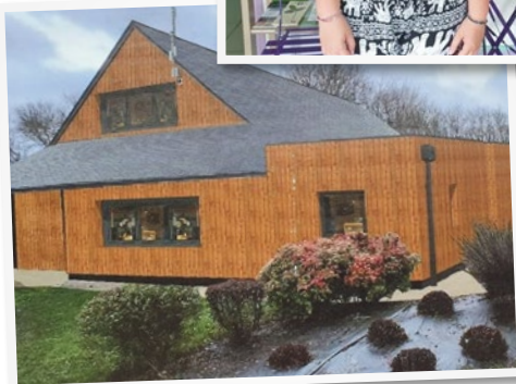
Projet rénovation du VVP
